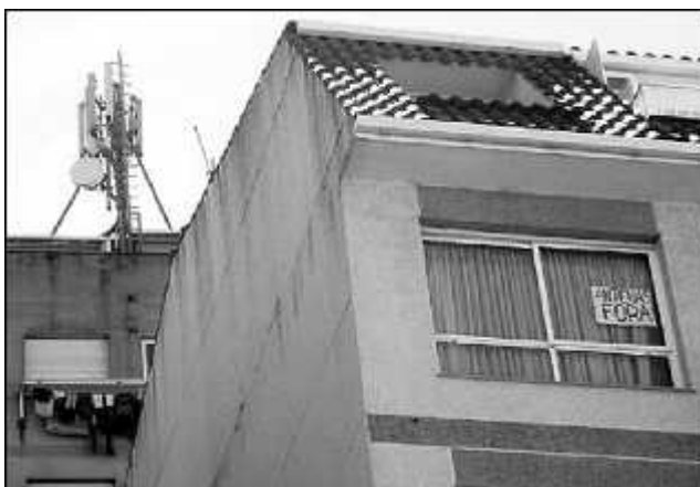
Una de las antenas de telefonía denunciada por los vecinos de Chapela y un cartel en una casa que pide su retirada
