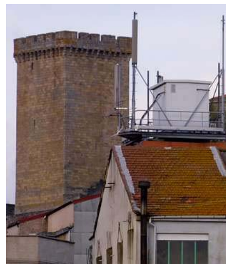
Foto de arquivo da antena de Vodafone na avenida de Galicia
