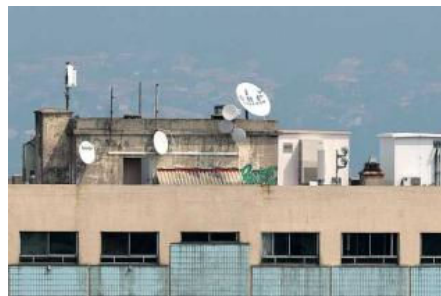
Antenas de telefonía móvil en la cubierta de un inmueble de Vigo. // R. Grobas
