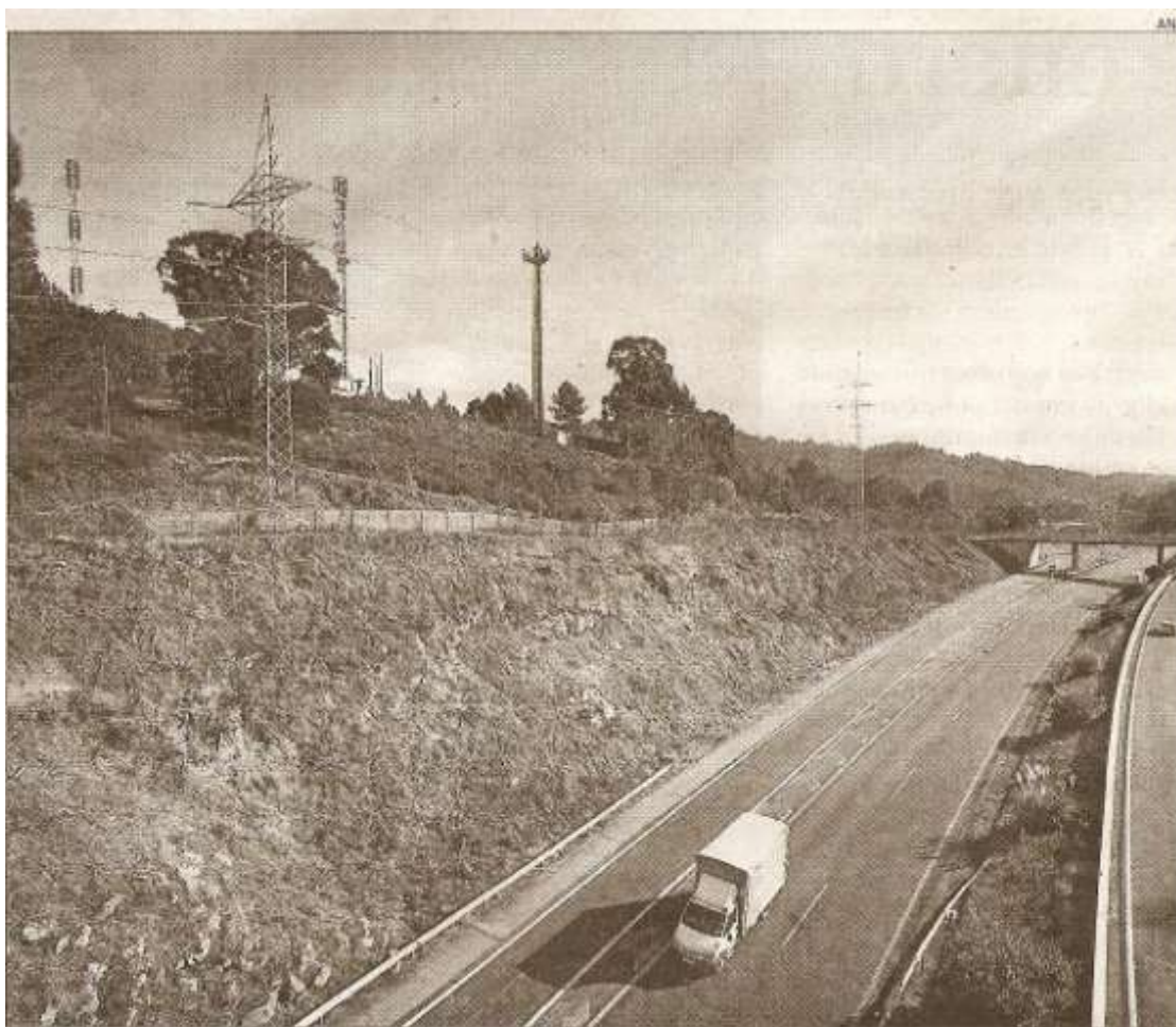
Vista desde la AP-9 de las tres antenas de telefonía móvil y la línea de alta tensión en Saxosa
