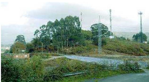
Vista del lugar de A Esculca en donde se encuentran instaladas tres estaciones de telefonía móvil y una torreta de alta tensión . Noé Parga
