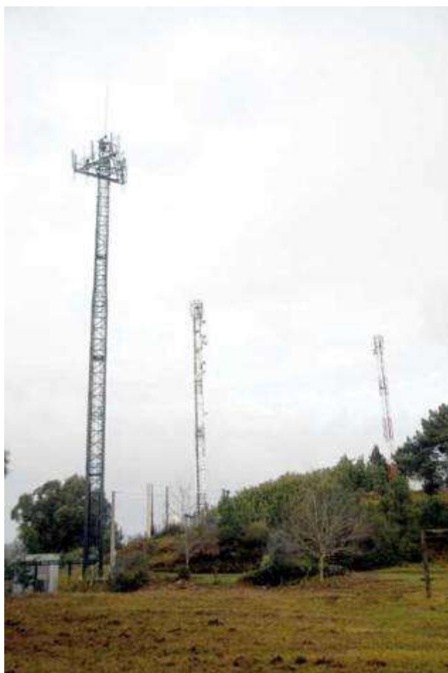
Antenas de telefonía móvil instaladas en Salcedo y Vilaboa. N. Parg
