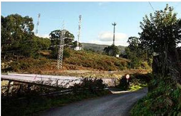
Las tres torres de telefonía móvil instaladas en la colina, con un tendido de alta tensión en primer término, vistas desde la AP-9
