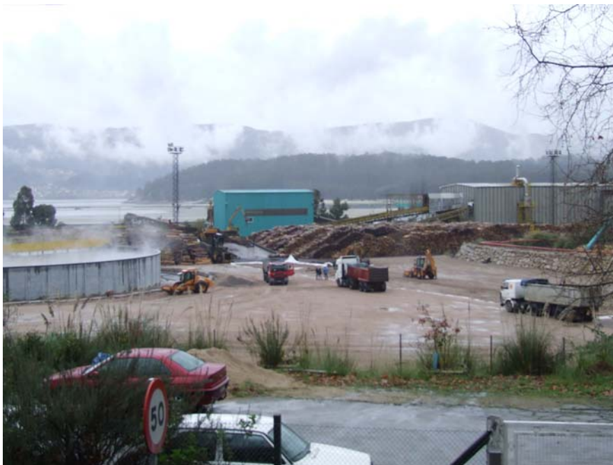
Obras que se están a realizar na actualidade
